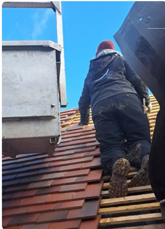
Mise à disposition du matériel au plus près du poste de travail.
