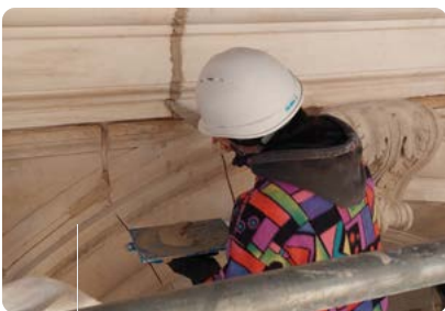
Réalisation du joint.
