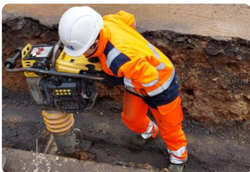
Manutention de la plaque vibrante pour le compactage
